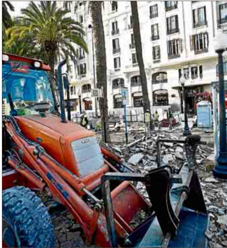
Obras que se ejecutan en la Explanada de Alicante. PILAR CORTÉS
