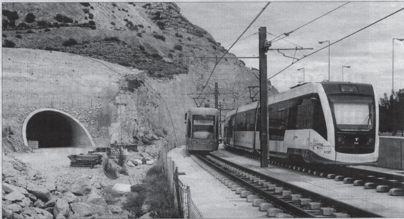
Un tranvía y el tren que conecta Alicante y Benidorm pasan ayer junto a la entrada del túnel de la Serra Grossa. PILAR CORTÉS
