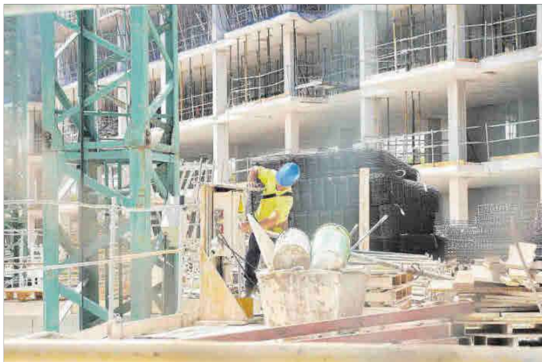
Un trabajador de la construcción en plena faena esta semana en un edificio de viviendas en Alicante.
