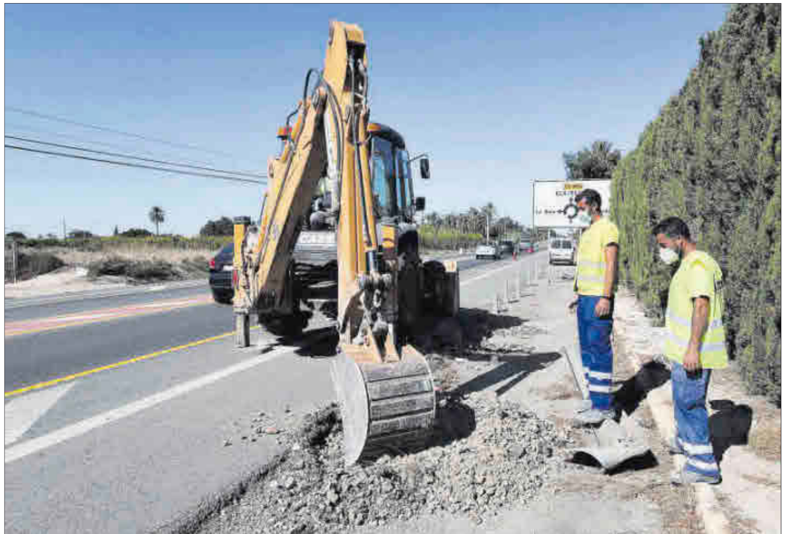
Obras en una carretera de Elche, en una imagen de archivo.
