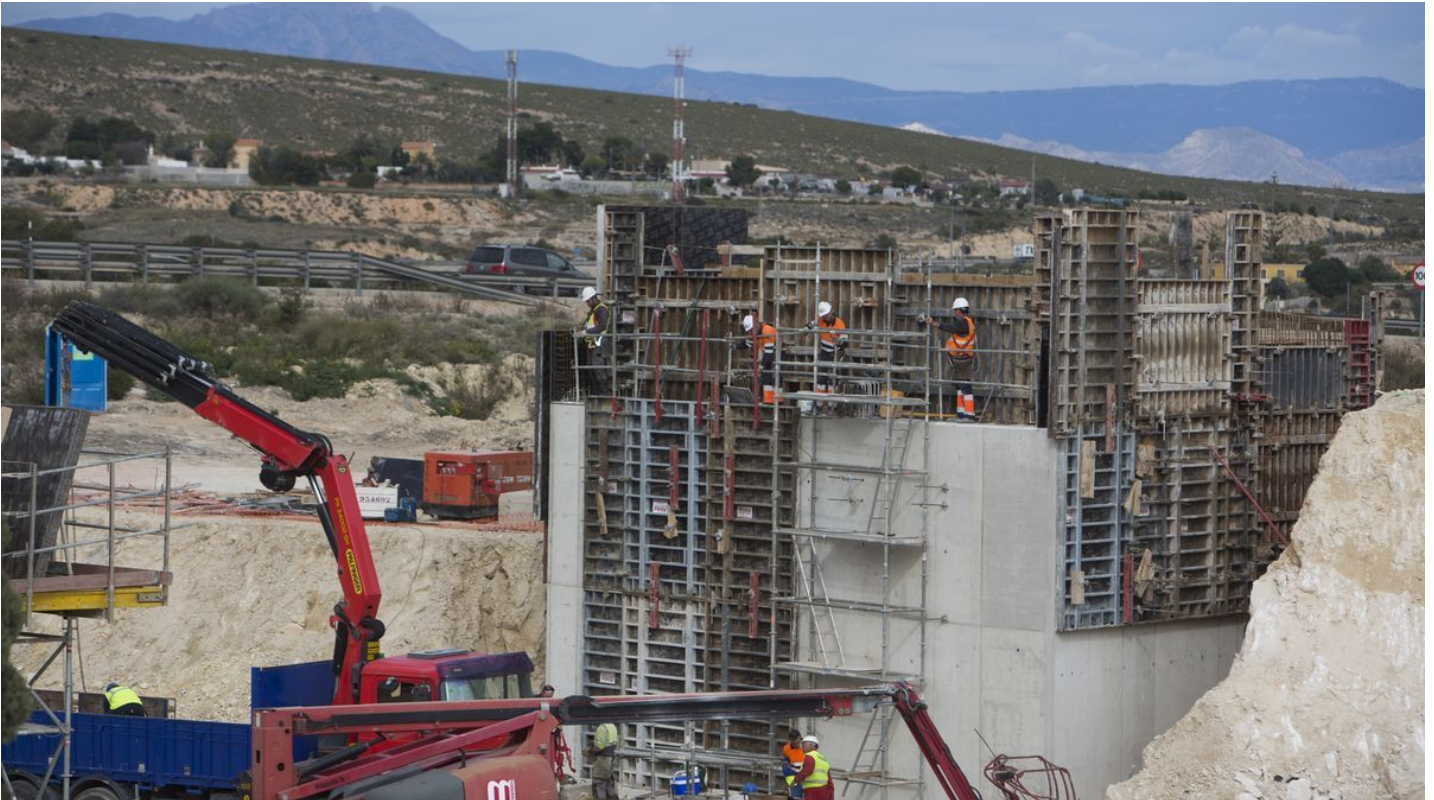
Obras de adecuación de los nuevos accesos viarios al aeropuerto en una imagen de archivo RAFA ARJONES
